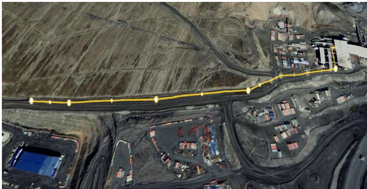
Рис. 3. Линия трубопровода от ЗИФ до первой станции гашения потока.
