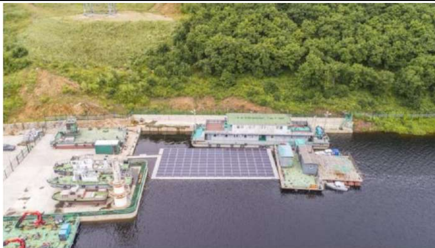
Рис.5. Солнечные панели, расположенные на Нижне-Бурейской ГЭС
