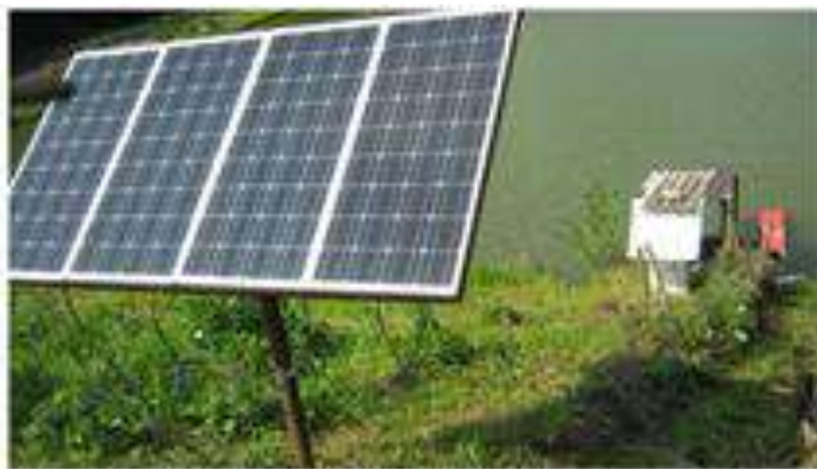
Рис.3. Установка микроГЭС - ФЭС
