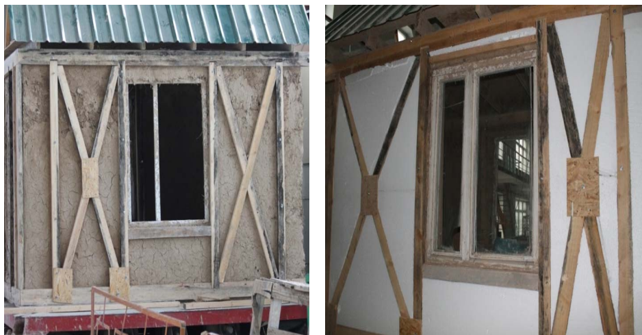
Рис.3. Установки каркаса и заполнения промежутков между стойками и раскосами утеплителем
