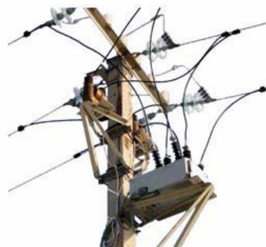
Рисунок 2. Вакуумный реклоузер
