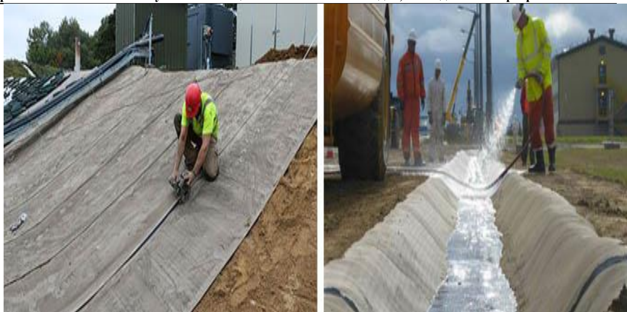
Рис. 2 а) укрепление откосов; б) укрепление траншей и канав.
