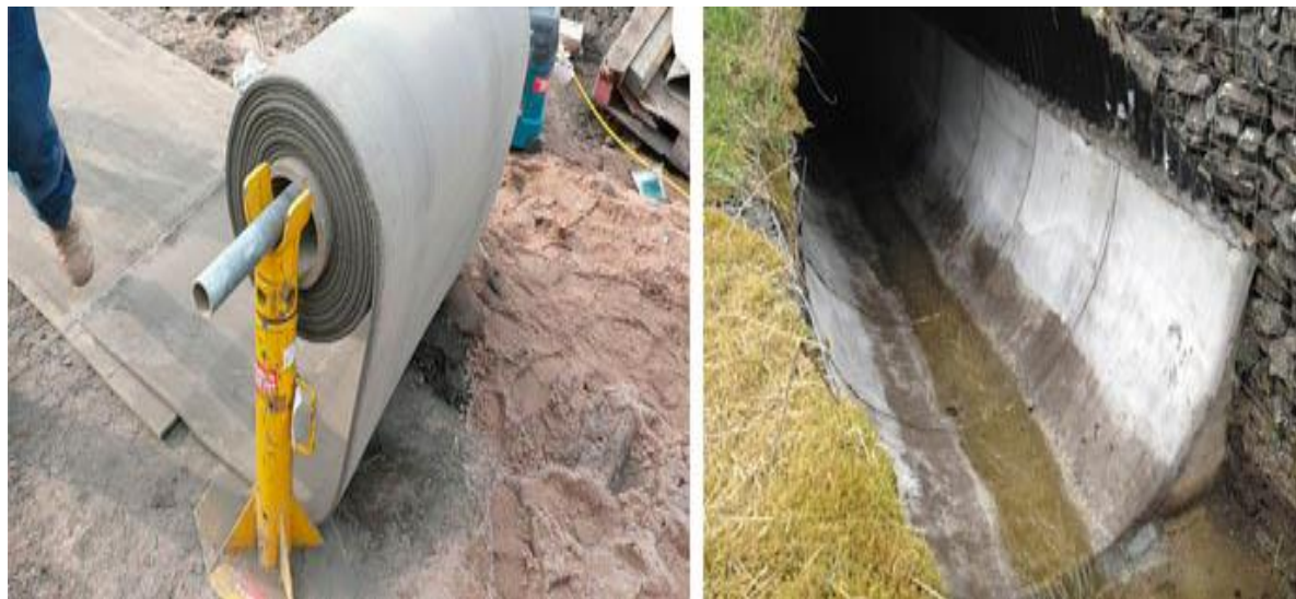
Рис. 5 а) рулон бетонохолста; б) бетонополотно использованное в виде канавы.
