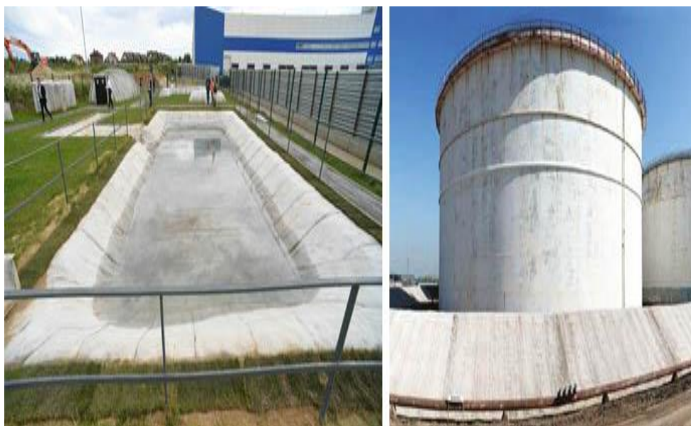
Рис. 4 а) укладка бассейна; б) использование бетонохолста в промышленности
