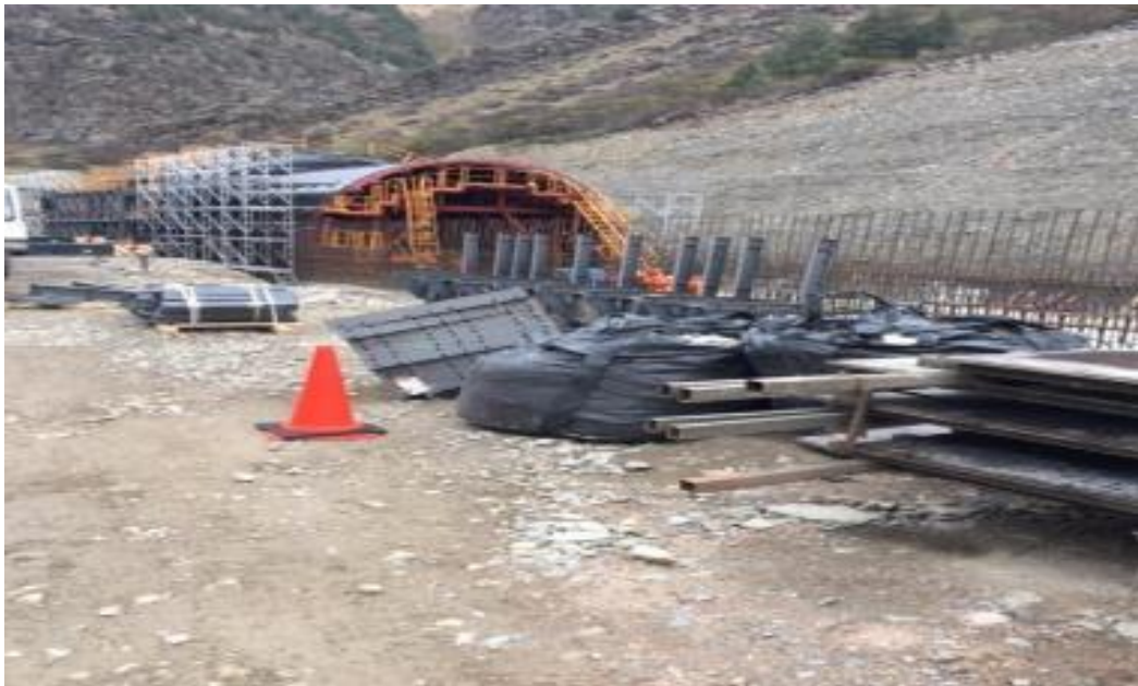
Рис.1. Строительство лавинозащитного сооружения в ущелье Чычкан
