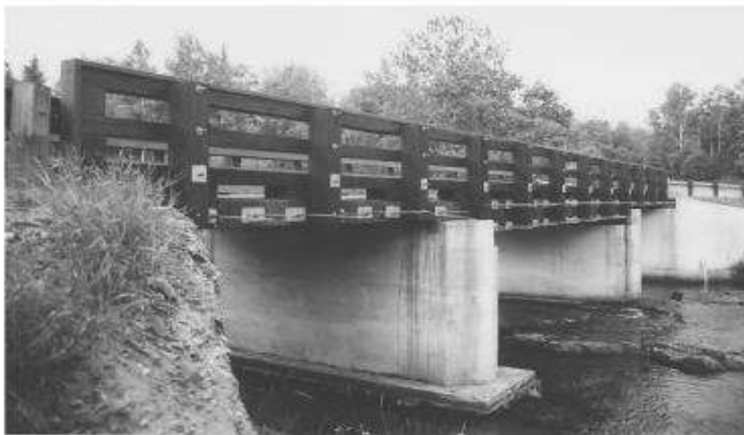
Рис. 1. Общий вид моста с предварительно напряженной многослойной деревоплитой. Мост Большого Эрика на р. Гурон (Big Eric's Bridge, Huron river) [7]
