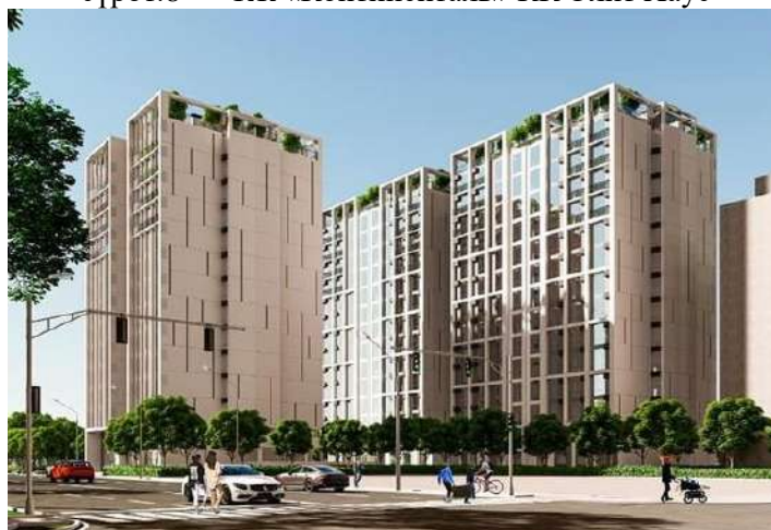
сүрөт.9 ТЖ «ALFA TOWERS» КК Альфа.
