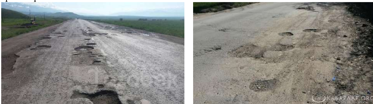
Рис. 3– Участок автодороги Бишкек-Ош 450км)
