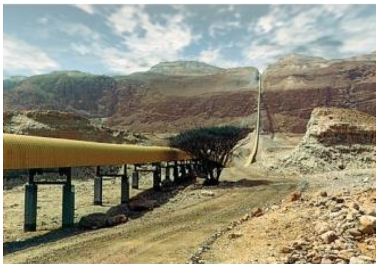
Рис 1. Канатно-ленточный конвейер, проложенный в условиях гористой местности.
